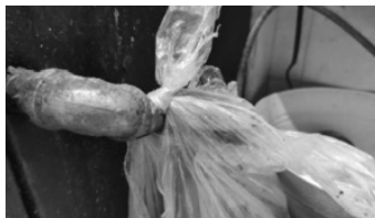
Figura VIII.12 Uso incorrecto de las conexiones de gas.
