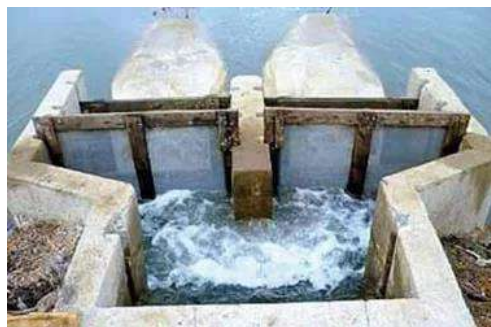
c). Compuerta de entrada
