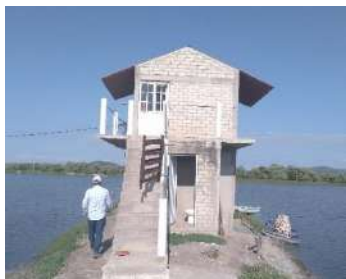
b). Unidad habitacional para trabajadores y bodega.
