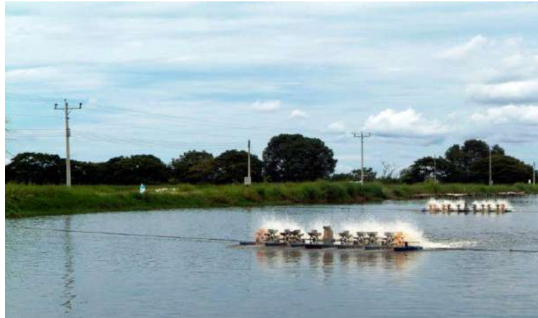
Red eléctrica implementada en una granja camaronera. Localidad San Blas
