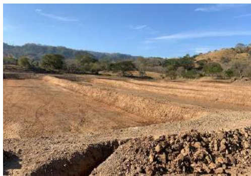
a). Construcción de una granja camaronera. Localidad La Chiripa
