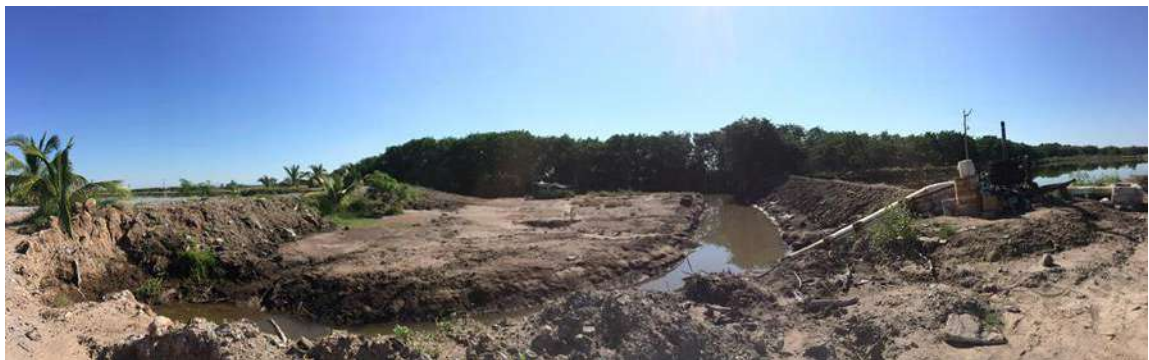
Granja camaronícola seca, aún dañada por el huracán Willa. Fotografía tomada el 1 de febrero de 2019.
