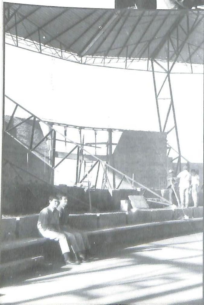
Mesón de los Deportes interior 1968. Arq. Carlos Aguiar y Rogelio Branbila. 2da. etapa: construcción de muros exteriores
