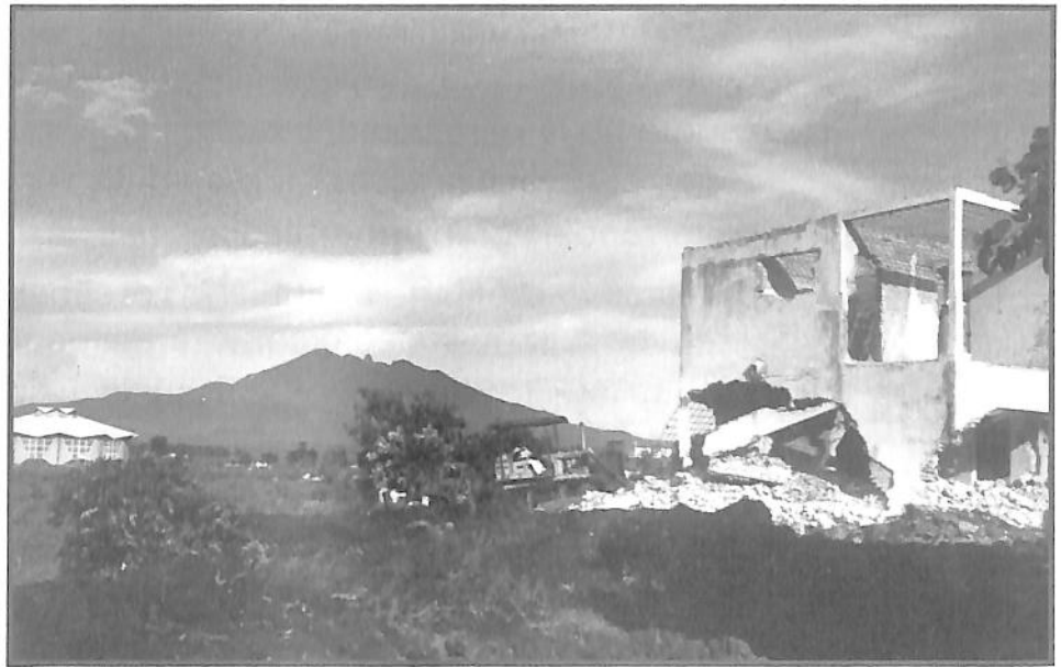
Demolición de construcciones existentes sobre el Boulevard. 1968.
