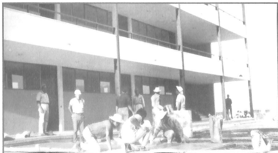
Escuela Normal Superior. Colocación de piso en patio. 1969.
