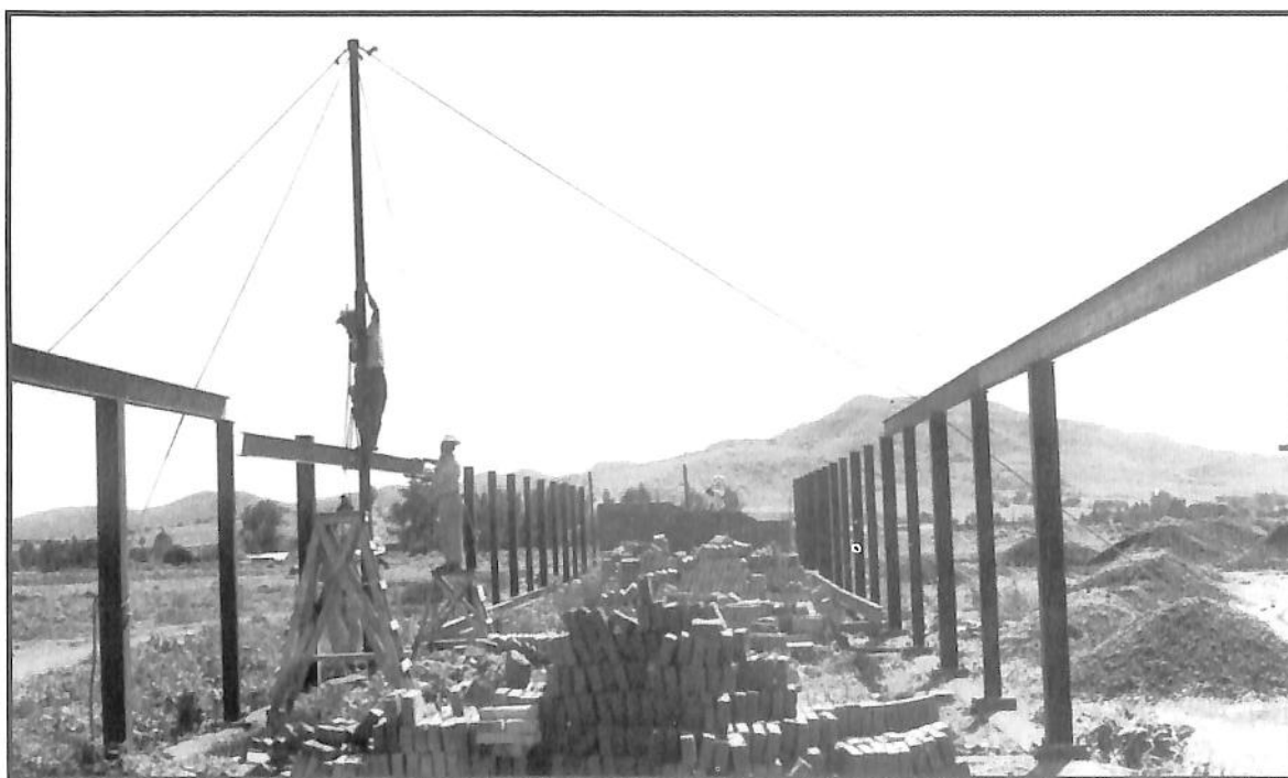
Colocación de estructura metálica. Escuela Preparatoria.
