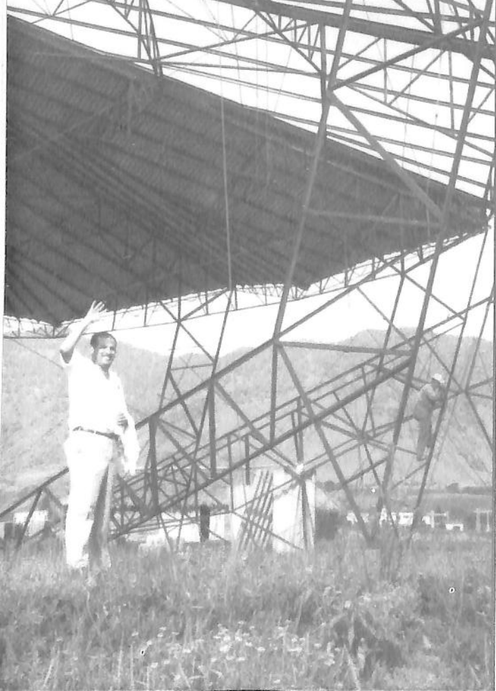
Colocación de láminas.
