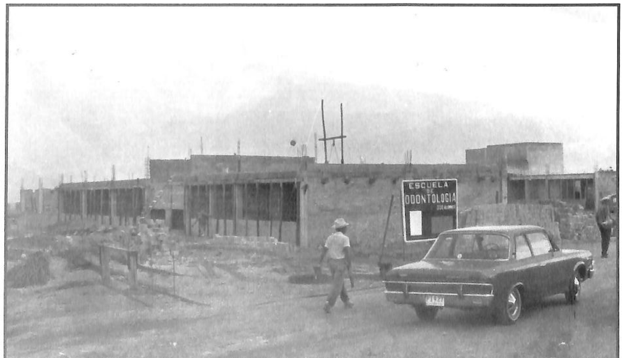
Escuela de Odontología, proceso de construcción
