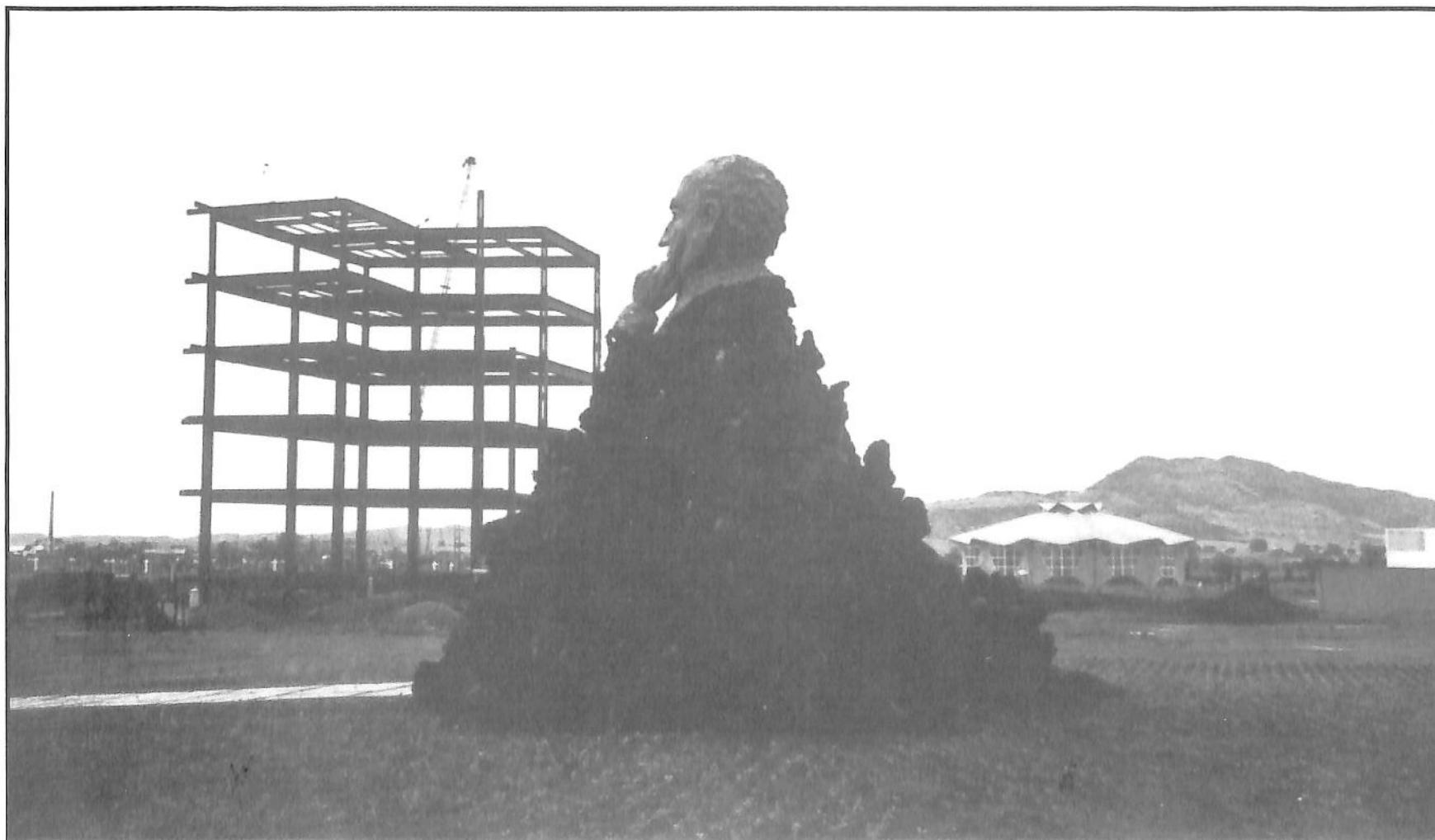
Torre de la Rectoría. Proceso de construcción
