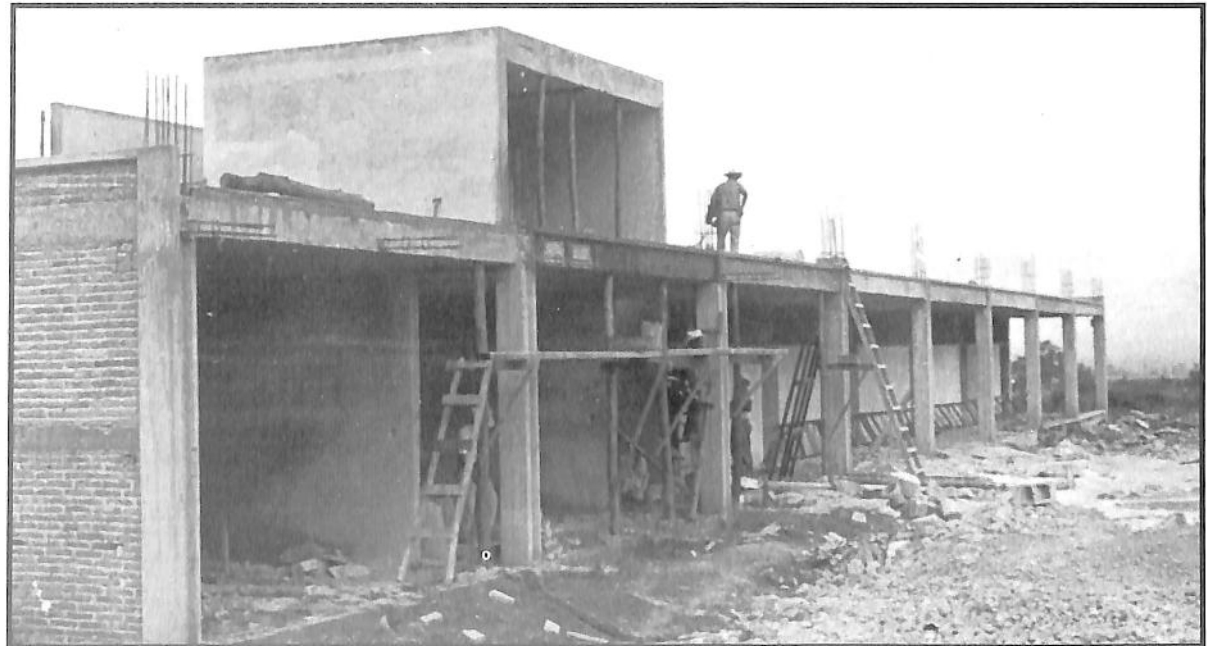
Escuela de Comercio en proceso de construcción. 1968.
