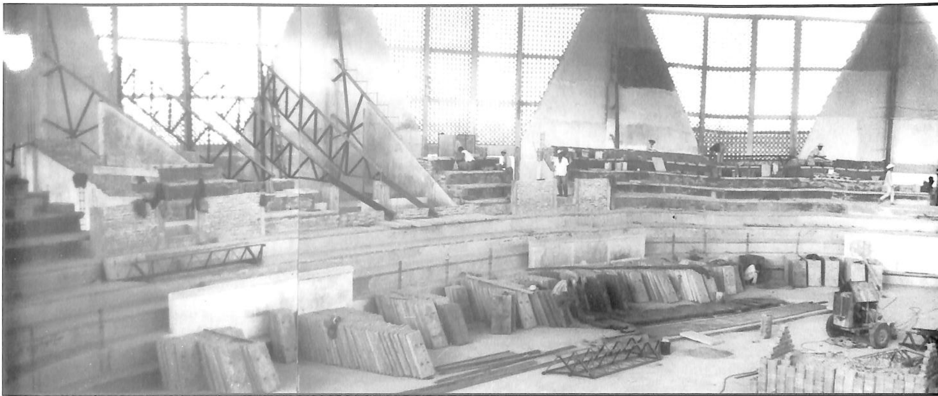
Mesón de los Deportes 1968. Colocación de losas y estructuras en tribunas
