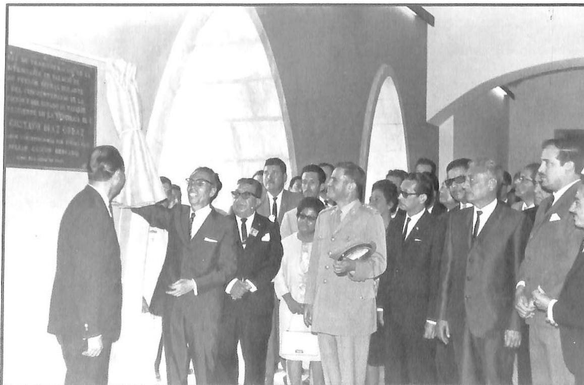
El Presidente Gustavo Díaz Ordaz, en la inauguración de la Planta Baja de Palacio de Gobierno (antigua penitenciaría) 5/febrero/1967.
