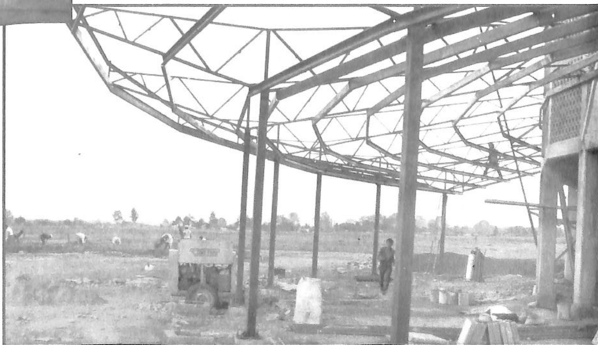
Construcción del portico de El Mesón de los Deportes.
