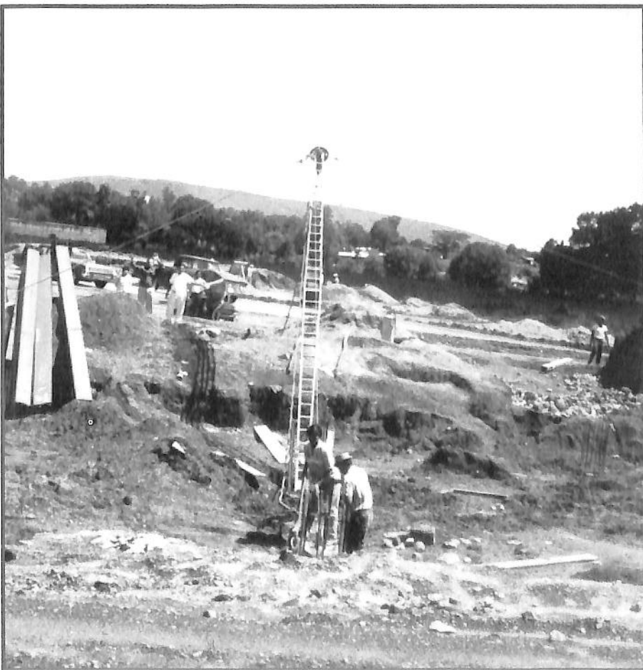
Edificio Torre de la Rectoría. Inicio de la estructura metálica. VII/6.
