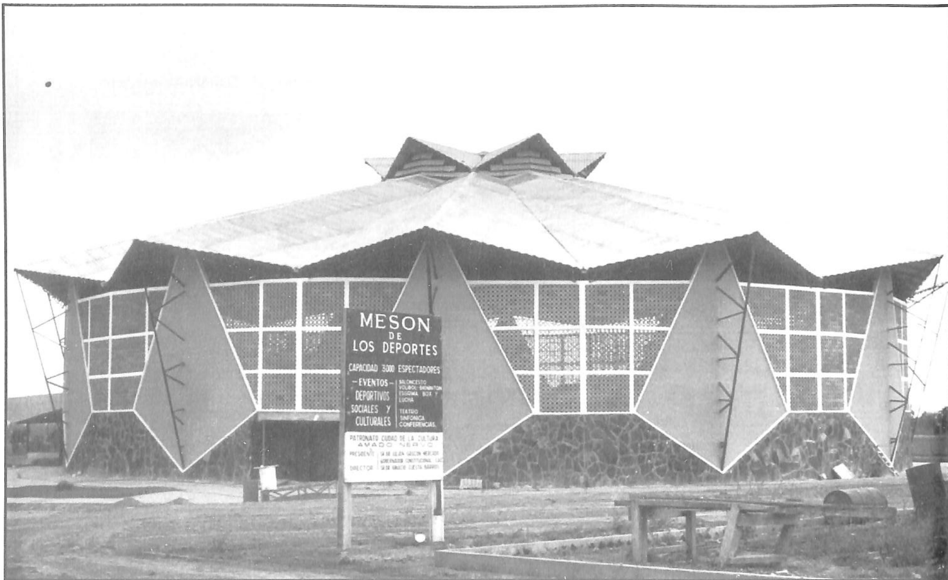
Primeras imágenes de la obra casi terminada.
