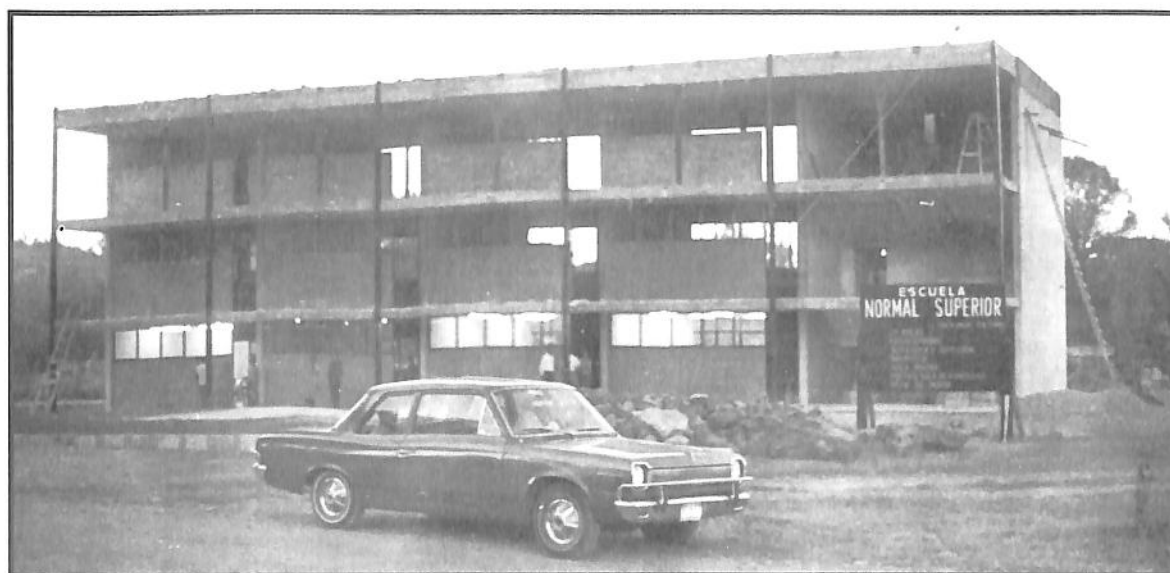
Escuela Normal Superior. Proceso de construcción. 1968.
