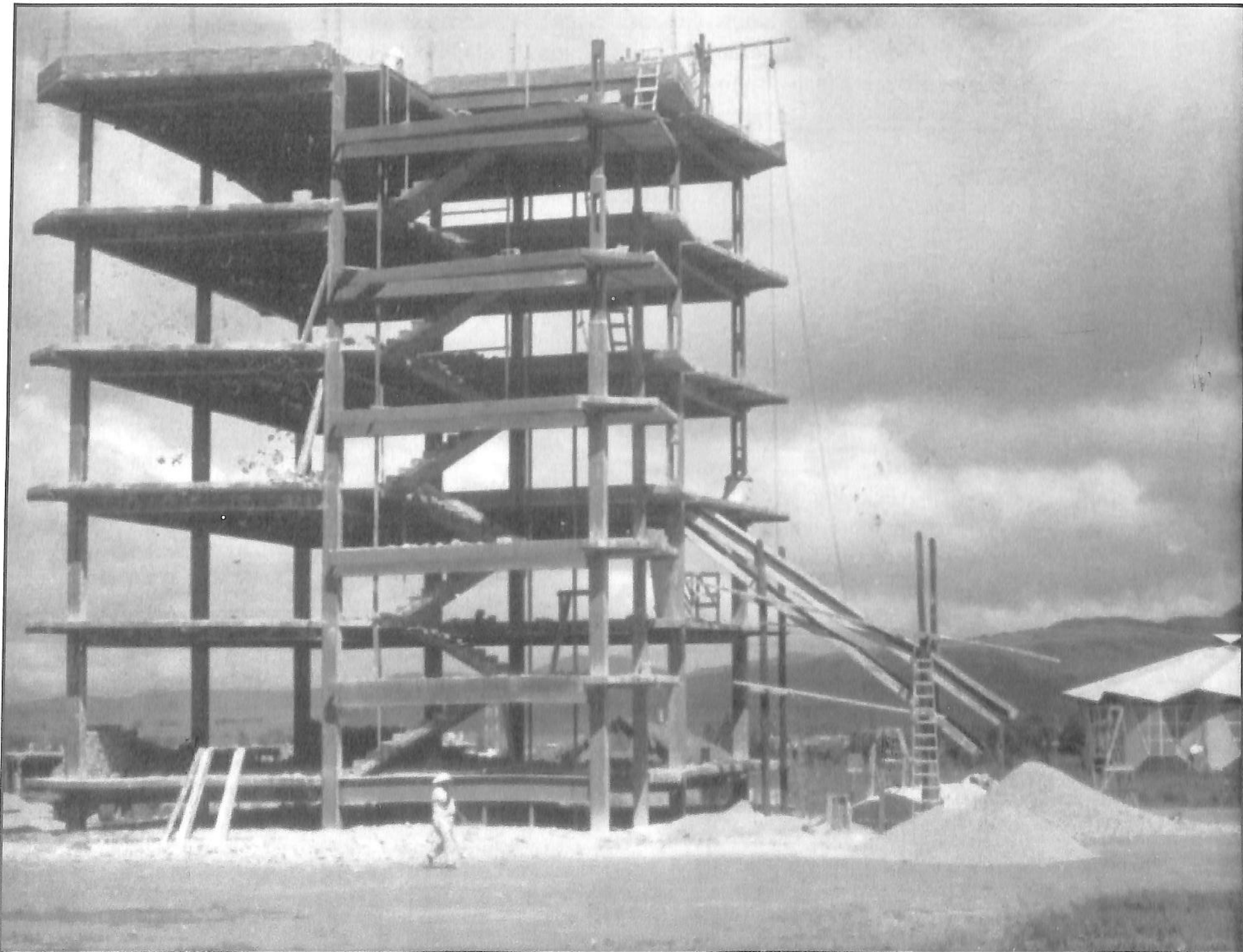
Torre de la Rectoría en construcción. VI-69
